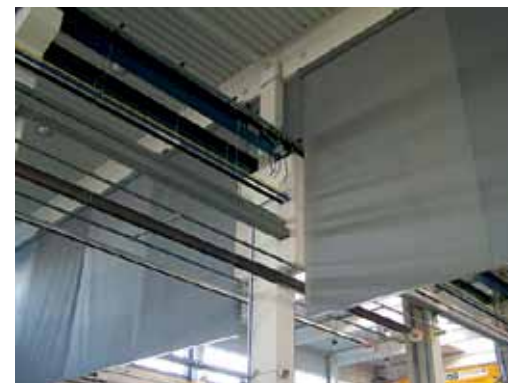
SM5 mobil füstkötényfal
