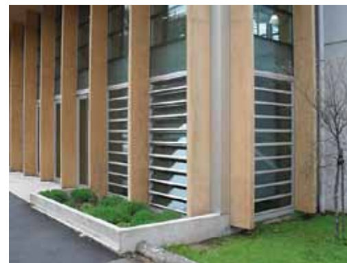
Komfort környezet – Coltite füstelvezető, vágó frisslevegő bepótló zsalu
